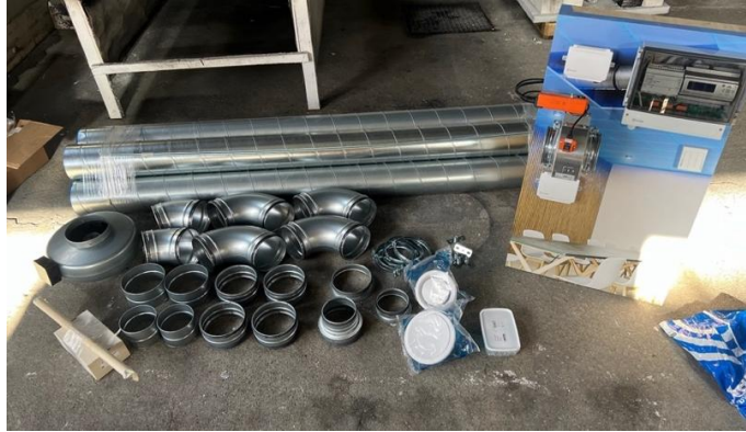
Figur E.1: Oversikt over komponentene til ventilasjonsanlegget
